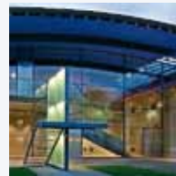
D Neues Foyer
